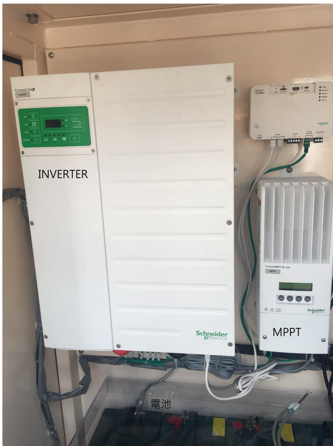
圖 5 本案對各住戶所設置的換流器(XW5548)外觀
